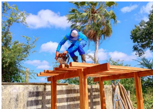
Figura 79: Montagem da estrutura da caixa d'água.
