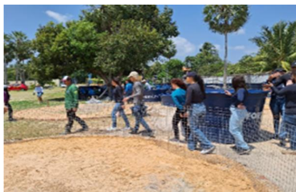
Figura 76: Início da montagem dos tanques.
