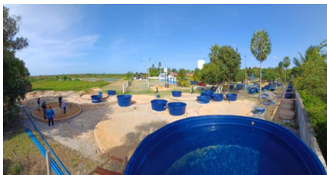
Figura 82: Vista da caixa d'água;
